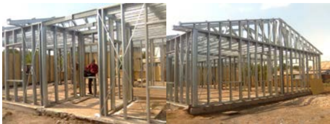
Рисунок 2 - Возведение каркаса по технологии ЛСТК
