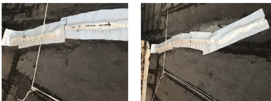
Рисунок 3 – Заделка трещин
