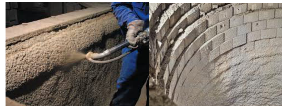
Рисунок 3 – Торкретирование разливочных ковшей
