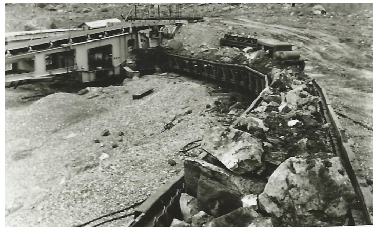
Сурет 1 – Качканар КБК тәжірибелік-өнеркәсіптік учаскесінде П-80К қатпарлы конвейері
